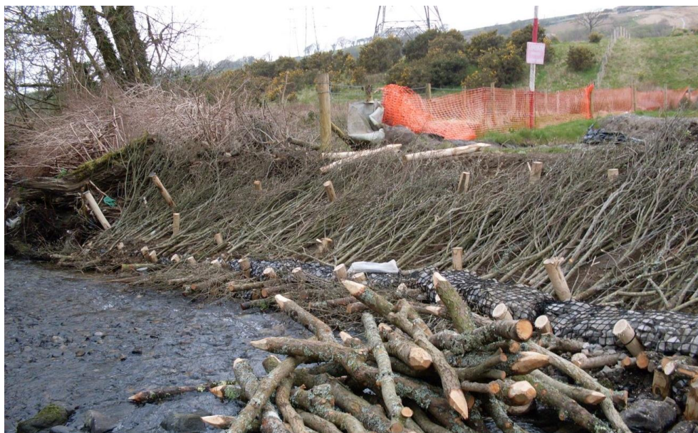
Фигура 4.30 Изглед към откос, укрепен с пластове от върбови клони и защита на петата със скални валяци (24)
