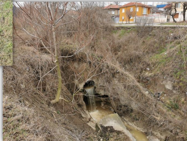
Ерозия на дъното и свличане на десен бряг при заустване на канализационен колектор след преминаване на високи води Източник на изображението: личен архив 02.2021 г.
