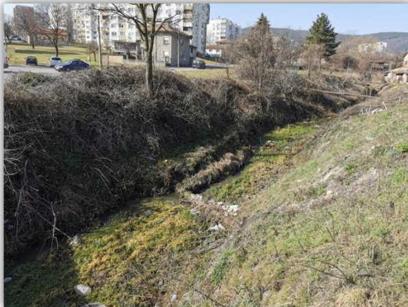
Покачване на дъното на р. Енчова (гр. Шумен) в резултат от изграждане на бараж надолу по течението Източник на изображението: личен архив 02.2021 г.
