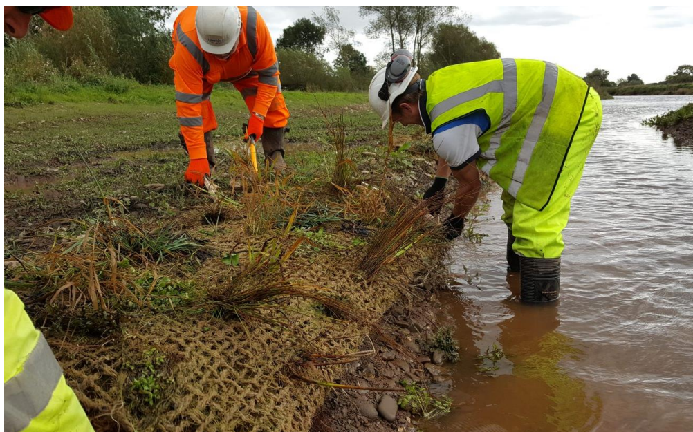
Фигура 4.32 Полагане на кокосова рогозка върху откоса (24)
