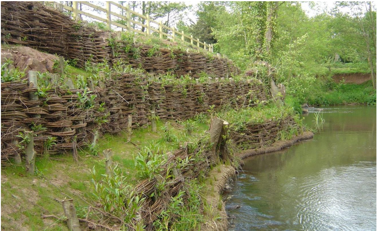
Фигура 4.37 Върбови плетове след започване на развити на растителността (24)
