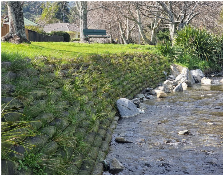
Фигура 4.41 Укрепване на брега с армирана пръст – общ изглед (25)
