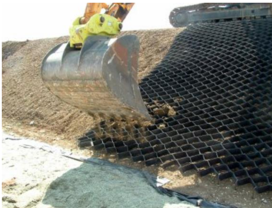
Фигура 4.39 Гео-клетъчна система за укрепване на откоси
