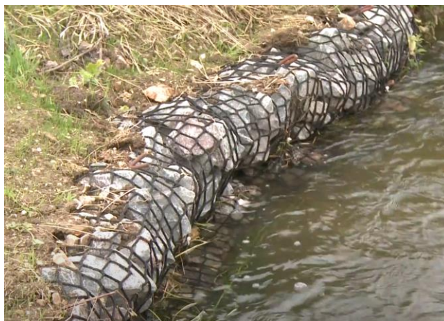
Фигура 4.17 Укрепване на петата на откоса със скални валяци (23)
