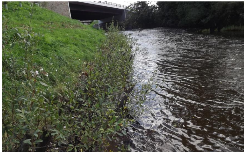
Фигура 4.20 Скален валяк с върбови клонки (24)
