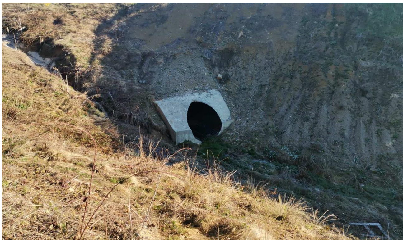
Снимков материал: Отводнителни съоръжения, служещи и за проход на животни.
