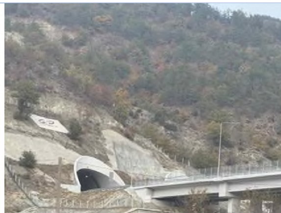
Снимков материал: Тунел Железница (южна страна) около порталите на тунела, двустранно в обхвата на магистралата - мрежи
