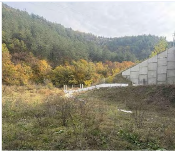
Снимков материал: предпазни огради около моста на р. Струма за ограничаване достъпа на дребни животни и влечуги
