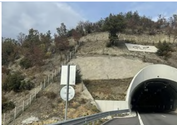
Снимков материал: Тунел Железница (южна страна) около порталите на тунела, двустранно в обхвата на магистралата - мрежи
