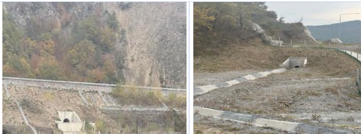
Снимков материал: тръбни водостоци по трасето на АМ „Струма“
