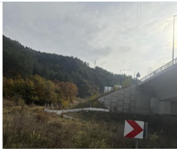
Снимков материал: предпазни огради около моста на р. Струма за ограничаване достъпа на дребни животни и влечуги
