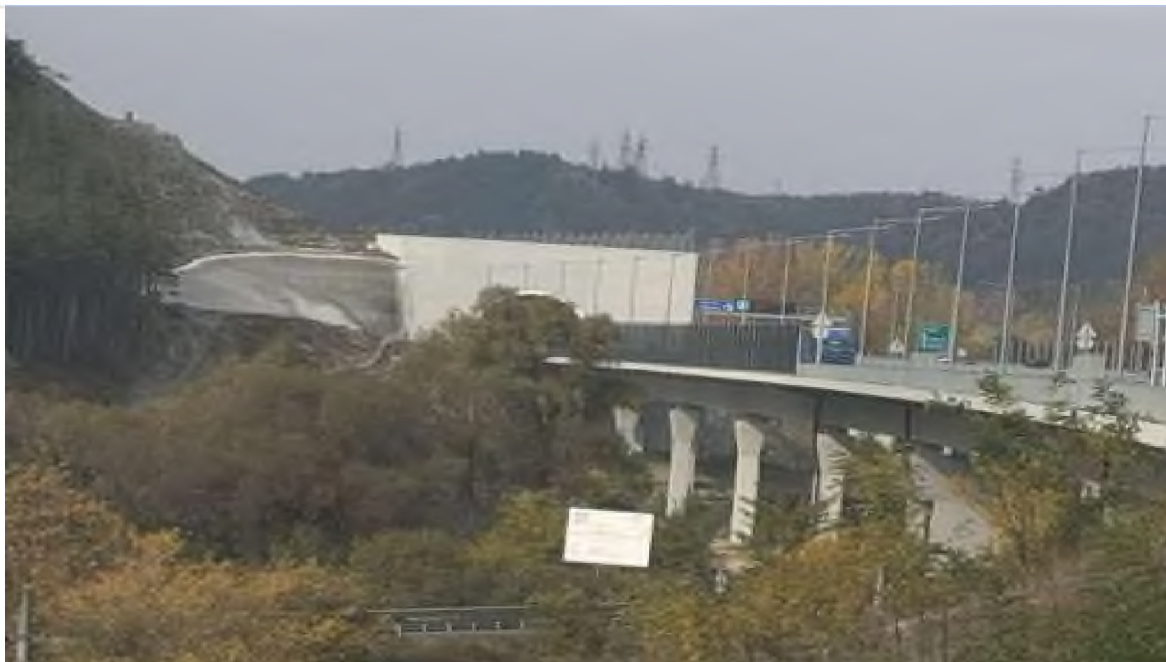
Снимков материал: Мост над р. Струма от км 366+000 до км 366+720 - мрежа за птици при пресичането на р. Струма - 408 м.
