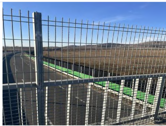
Снимков материал: изградени съоръжения на пътен възел на АМ при км 21+004, землище с. Алдомировци
